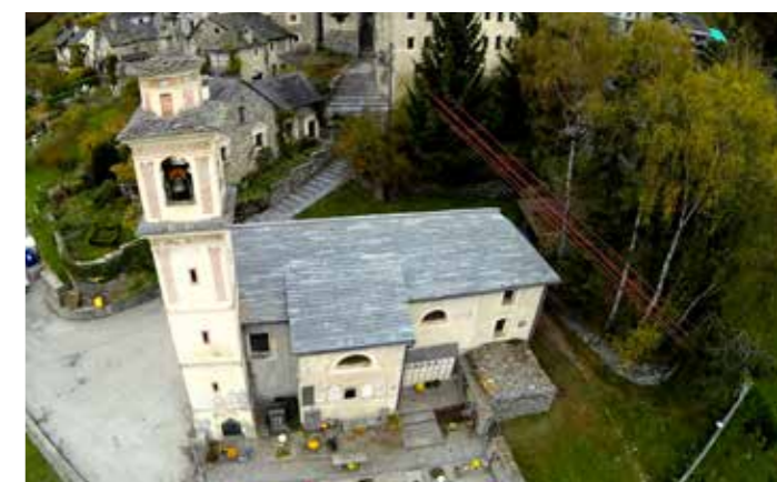
Das Dach ist saniert. Nun müssen noch die Ziegel des Glockenturms ersetzt und die Fassade neu gestrichen werden.
