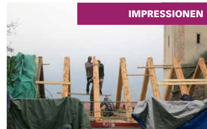
Mit robusten Balken wurde das Dach stabilisiert und verstärkt.
