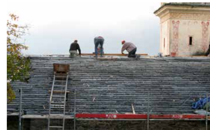
Ziegel für Ziegel wurde ersetzt. Nun ist das Dach wieder dicht.
