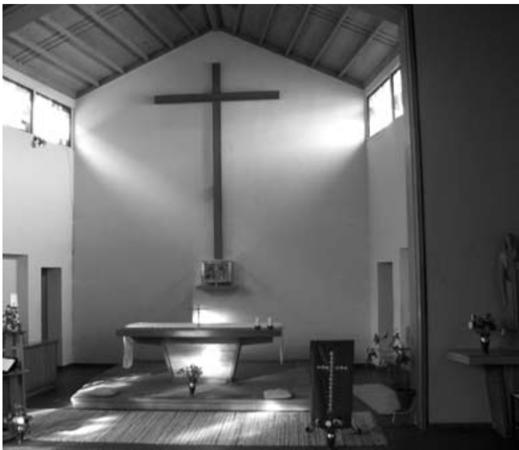
Die Balken sind morsch: Pfarrkirche von Les Agettes.
