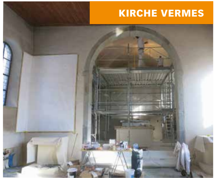
Aktuelle Restaurierungsarbeiten im Chor der Kirche.
