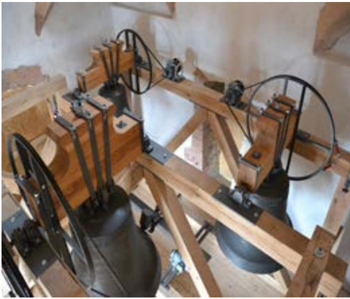
Blick in den renovierten Glockenstuhl eines Kirchturms.
