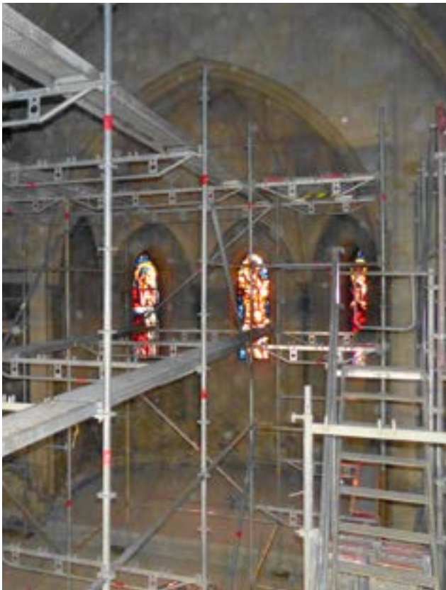
Blick auf das Gerüst in der Kirche mit dem Chor im Hintergrund. (Foto: zVg)
