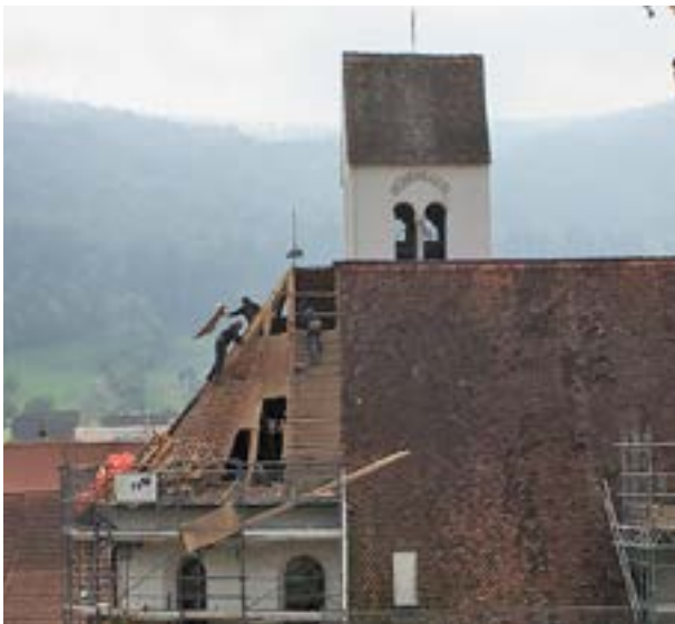
Dachsanierung in luftiger Höhe oberhalb des Chors der Kirche. (Foto: zVg)
