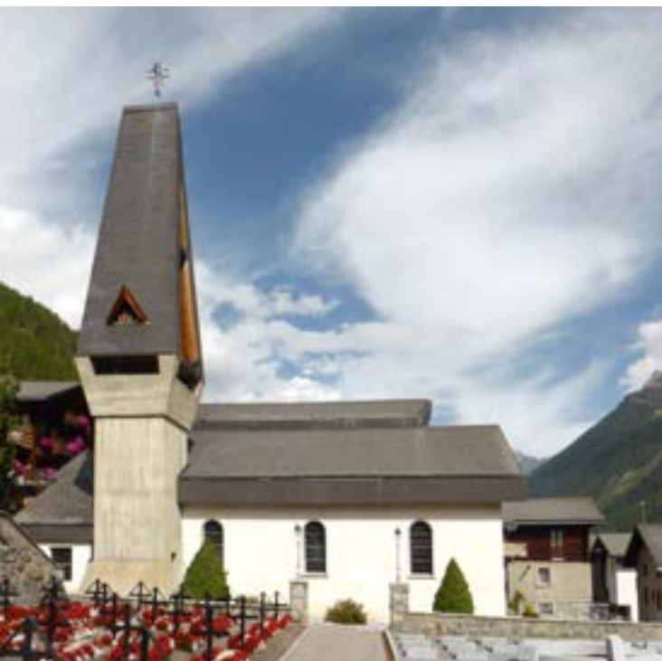
Die Kirche Königin des Friedens mit beschädigtem Dach.
