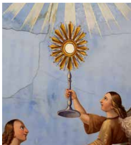
Le plafond présente des fissures. Certes, elles mettent en danger avant tout les peintures antiques. Mais si rien n'est entrepris prochainement, toute l'église risque de s'effondrer!
