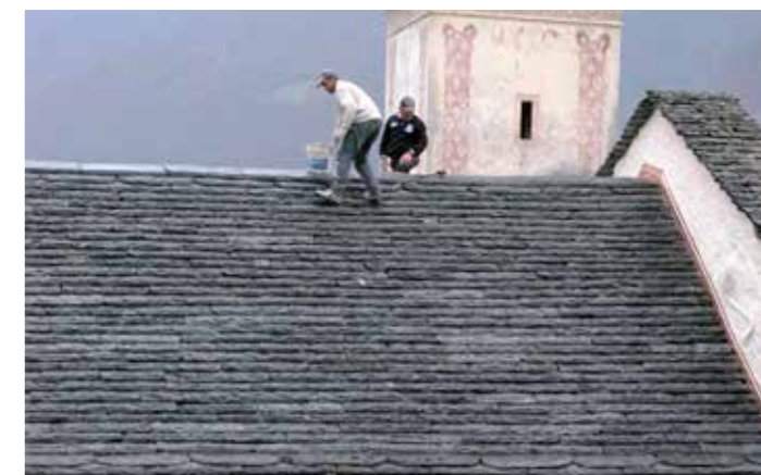
La rénovation créa de l'emploi dans le village montagnard excentré.
