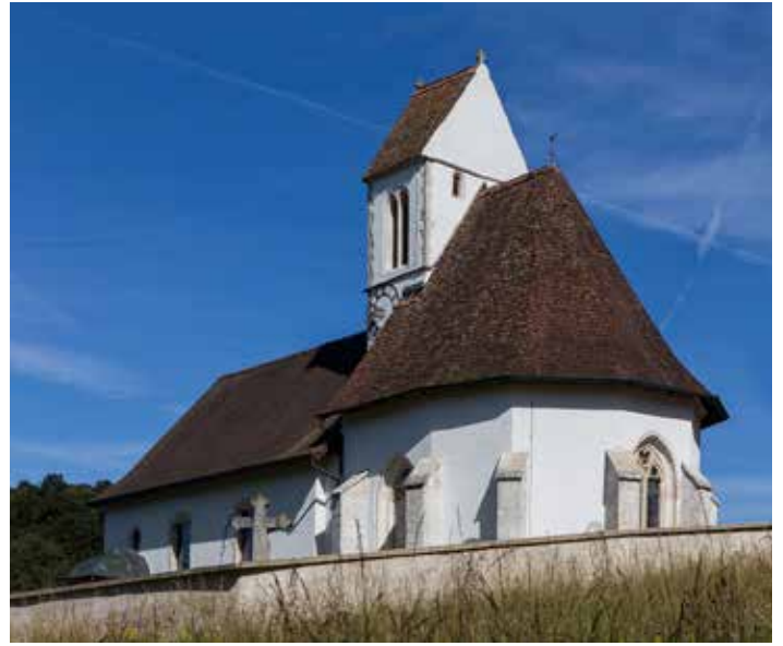
L'église St-Jacob rénovée de Beurnevésin.
