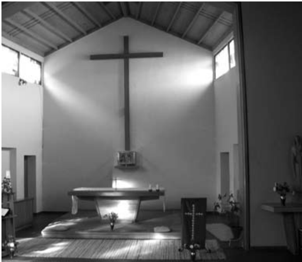
Les poutres sont pourries: église paroissiale des Agettes.
