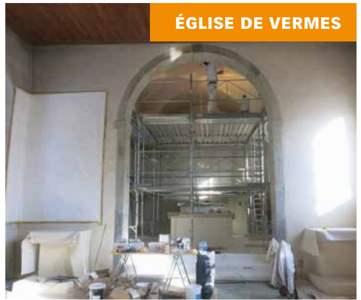
Travaux de restauration en cours dans le chœur de l'église. (Photo: ufw)
