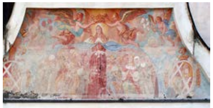
Vue de la fresque endommagée de la Vierge protectrice sur la façade sud de l'église avant la restauration. (Photos des deux pages: mäd)
