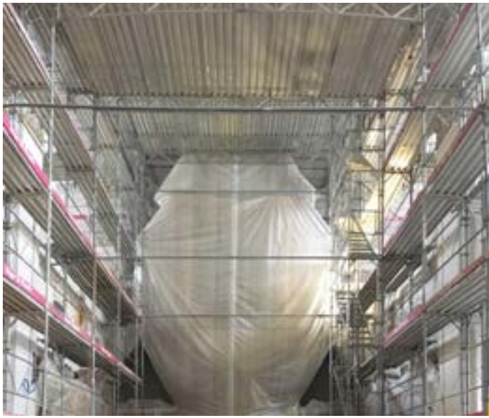
Les échafaudages à l'intérieur de l'église abbatiale à Disentis.
