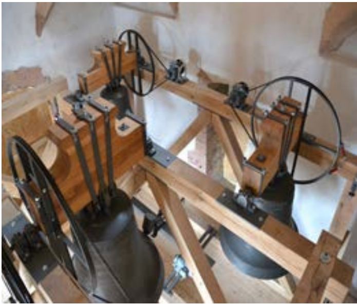
Le clocher d'une église et son campanile rénové.
