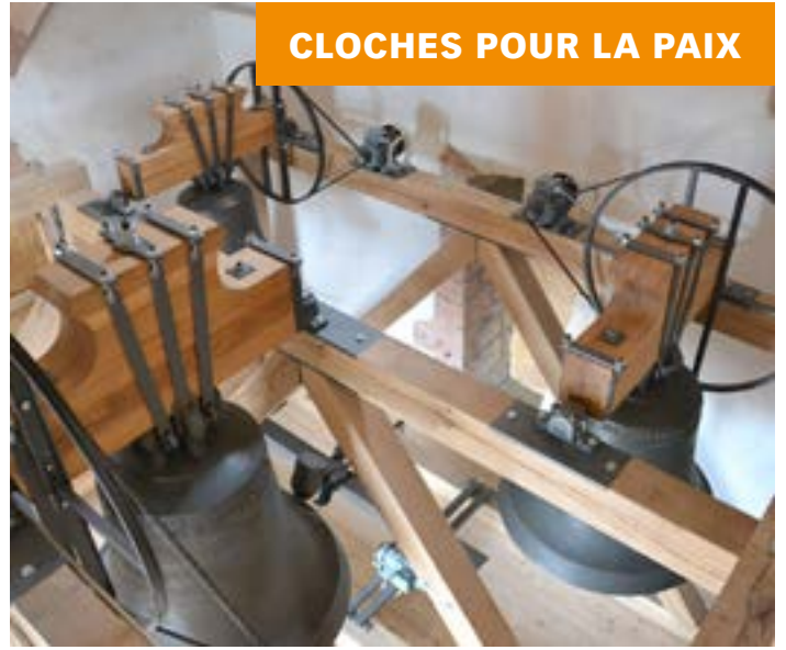
Beffroi en bois de chêne à St-Aubin (NE).
