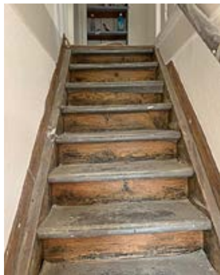
Ancien et nouveau dans le presbytère: la rénovation de l'escalier.
