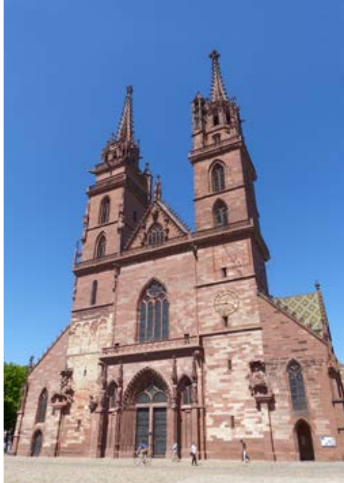
La façade occidentale de la cathédrale de Bâle consacrée le 11 octobre 1019. (Ph.: ufw)
