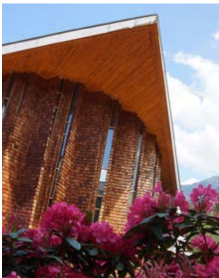
Vue de l'église conventuelle recouverte de bardeaux.
